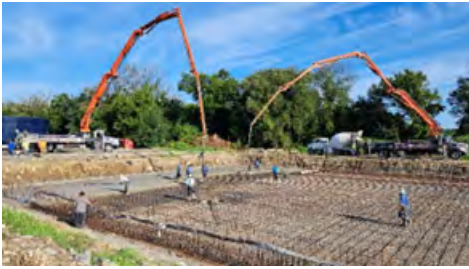
Pouring the Floor
